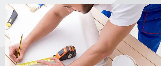
Строительные работы и ремонт помещений
